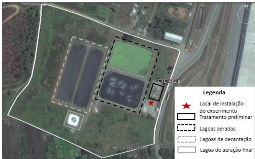
Figura 15: Vista aérea da ETE Arujá, SP, com destaque ao local onde foi instalado o experimento.
