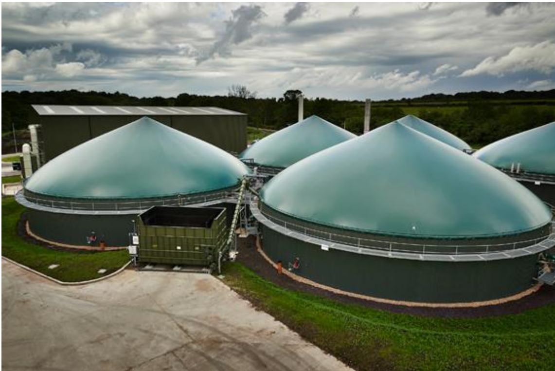
Figura 4: Unidade de digestão anaeróbia de sobras de alimentos no Reino Unido.
